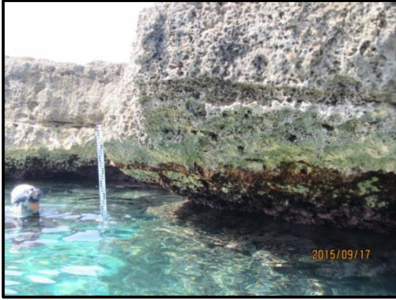
صورة (٦) احدى الفجوات الساحلية (Notches) "V" بمنطقة خليج "مادونا دي روكا فيكيا"، تصوير الطالبة في سبتمبر ٢٠١٥، أتجاه النظر نحو الجنوب الشرقي
